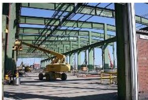
Gebäude werden bis auf das Stahlgerüst entkernt.
