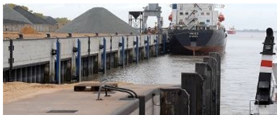
Die kleine Erweiterung im Seehafen mit vier Hektar ist im Grunde fertig, nur Versiegelung und Aufbauten fehlen noch, weil der Bebauungsplan noch aussteht. Foto Kordländer
