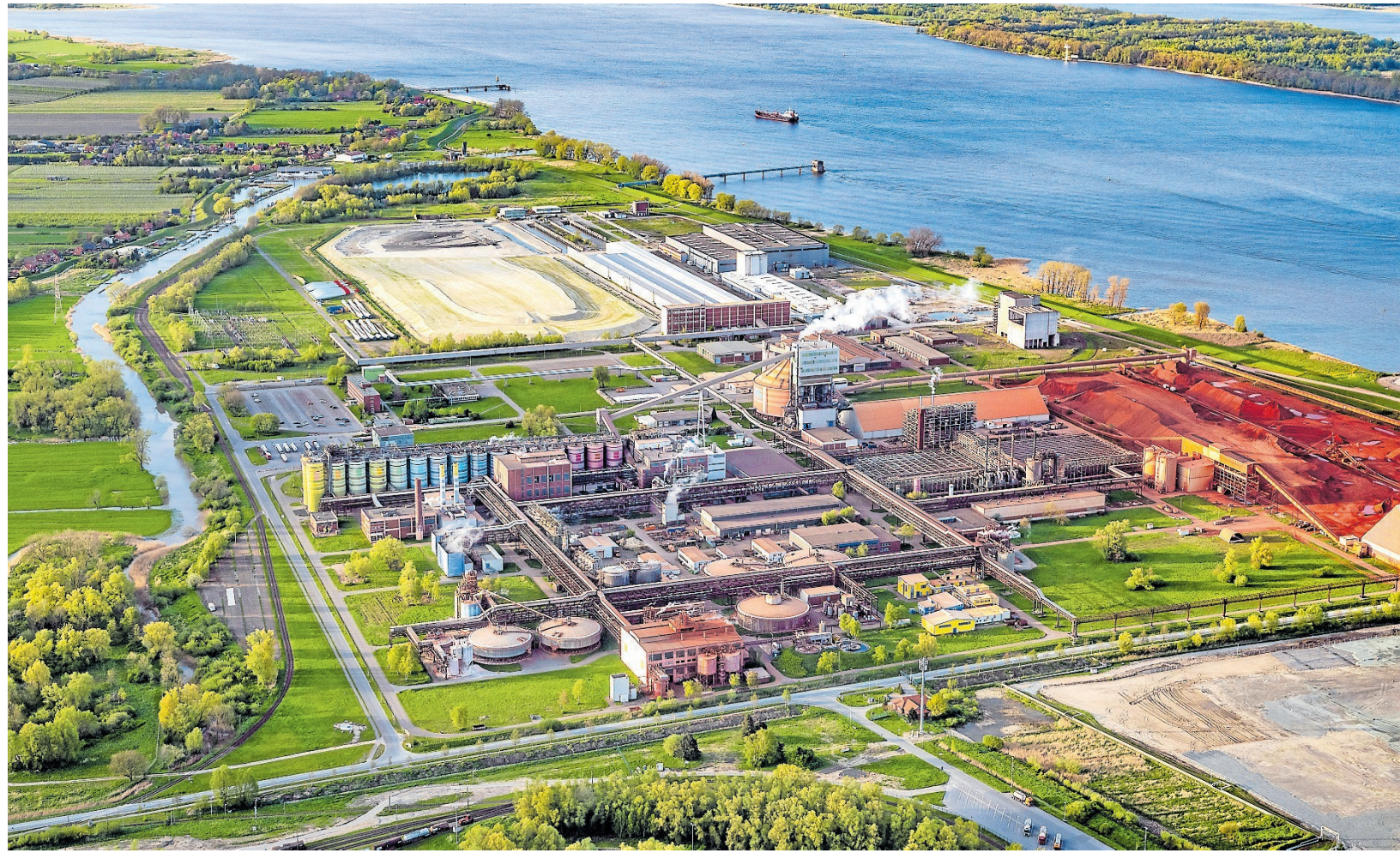
An der Elbe, direkt neben der AOS, soll das neue Heizkraftwerk entstehen. In der Bildmitte rechts steht die Ruine der einst geplanten Müllverbrennungsanlage. Der Sand zeugt von vorbereitenden Arbeiten. Foto: Martin Elsen
